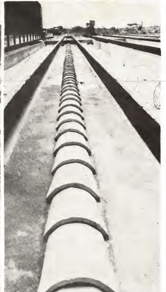
Ilier eca bed voordat het met steenslag wordt gevuld. De chemische oplossing met voedingsstoffen druipt door een kanaaltje onder de op elkaar gezegde pannen binnen. Un bista di un canal promé cu el a ser jená cu gruis. E awa cu ingredientenan kimico ta drehta bou di e panchinan cu nos ta mira uno riba otro.
